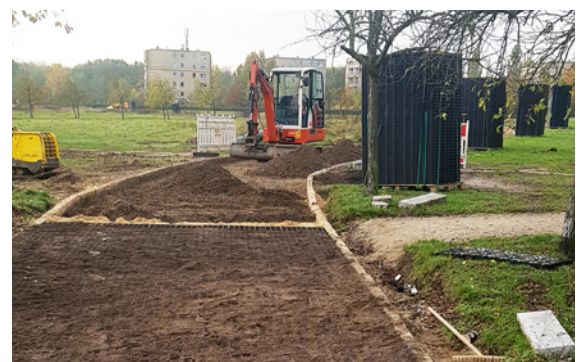
Der Boden wird für die Verlegung präpariert.
